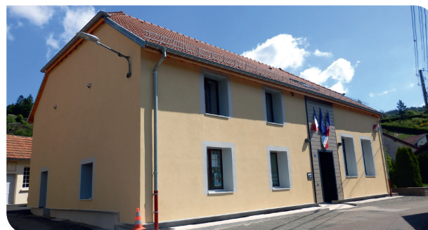
> Belfahy, avant et après isolation par l'extérieur
